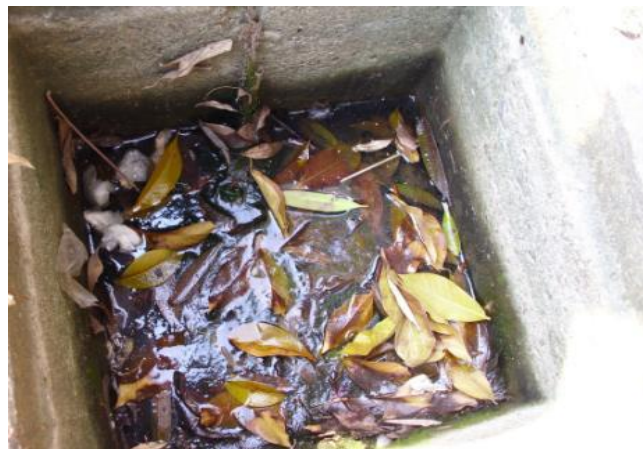
水溝.陰井.沉砂池
